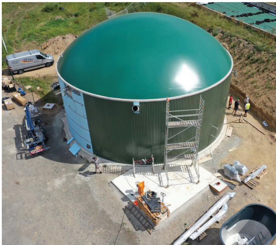
Výstavba jedné z nejmenších bioplynových stanic v ČR o výkonu 99 kW
