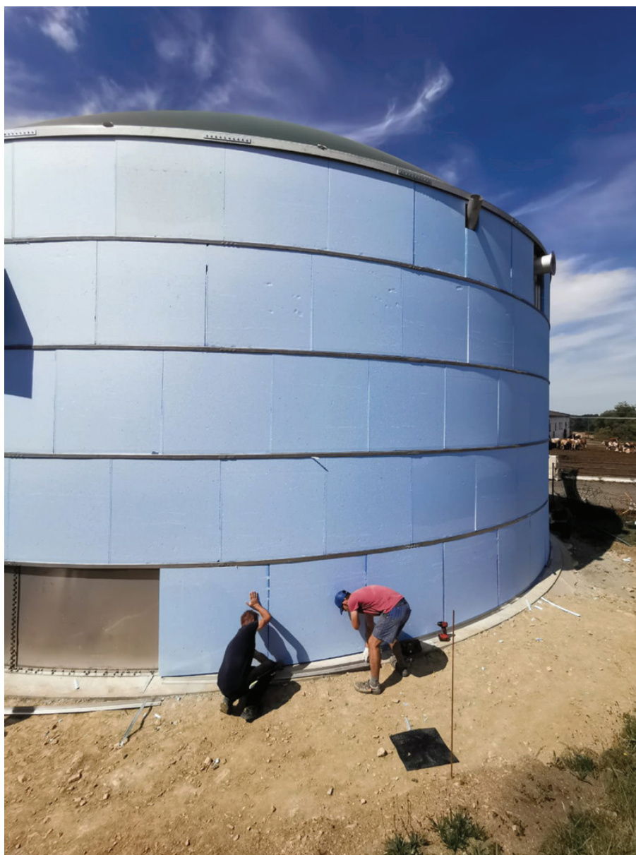
Výstavba jedné z nejmenších bioplynových stanic v ČR o výkonu 99 kW
