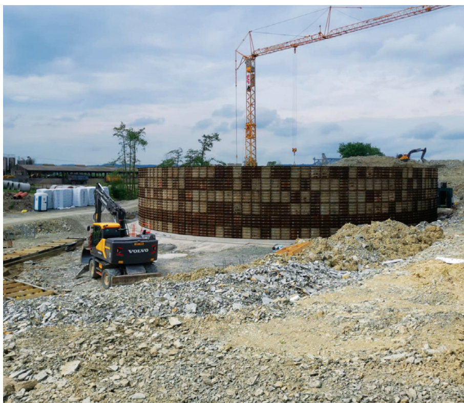
Výstavba BPS u velkokapacitního kravína měnící kejdu a zbytky na energii pro celou farmu
