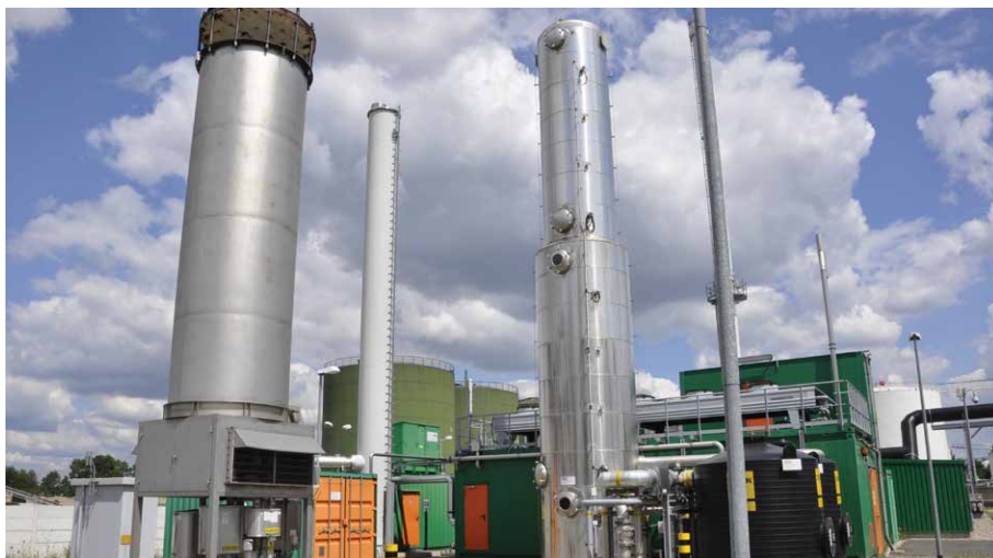
Flóra a technologie čištění bioplynu – aminová vypírka (Foto: Adam Moravec)
