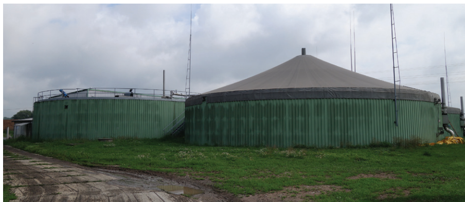
Celkový pohled na bioplynovou stanici
