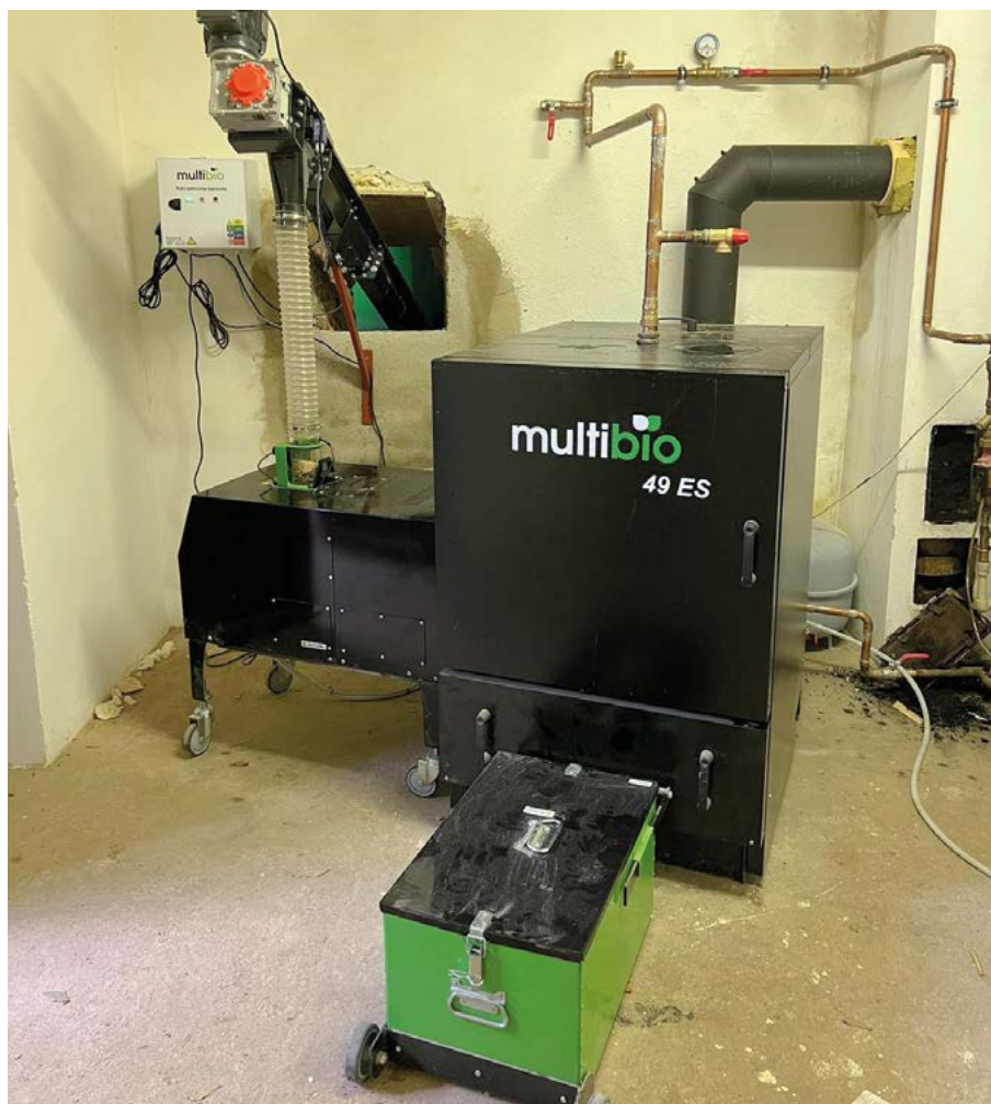
Obrázek 1: Kotel MultiBio 49 ES na drobnou štěpku a pelety (zdroj: Jindřich Sinkule)
