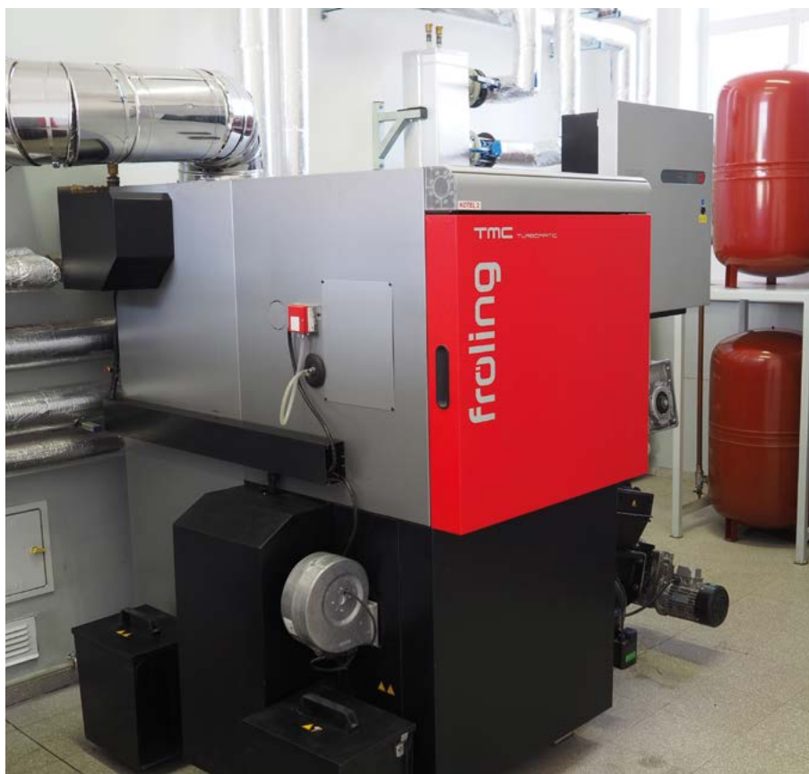
Obrázek 1: Řezankou z ozdobnice se dá topit v kotlích na štěpku a tato paliva lze střídat bez složitých přenastavování (zdroj: Lukáš Sovák)
