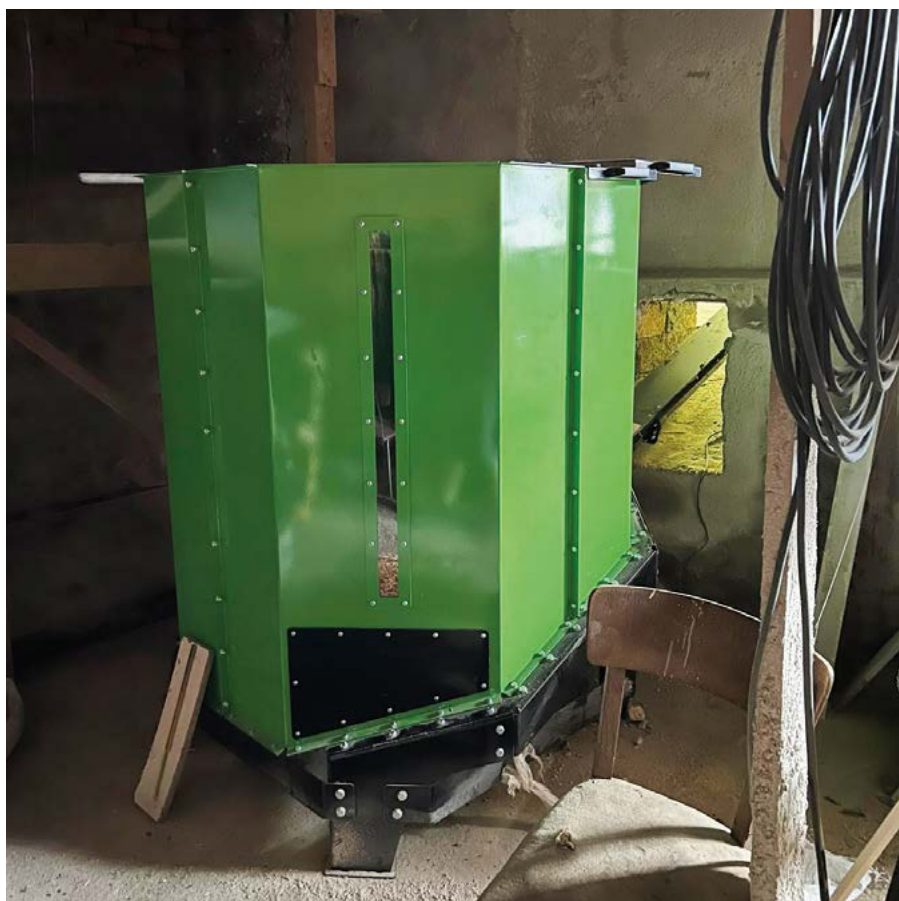
Obrázek 2: Násypka NS MultiBio 1600 litrů s míchacím mechanismem na štěpku ve dnu (zdroj: Jindřich Sinkule)
