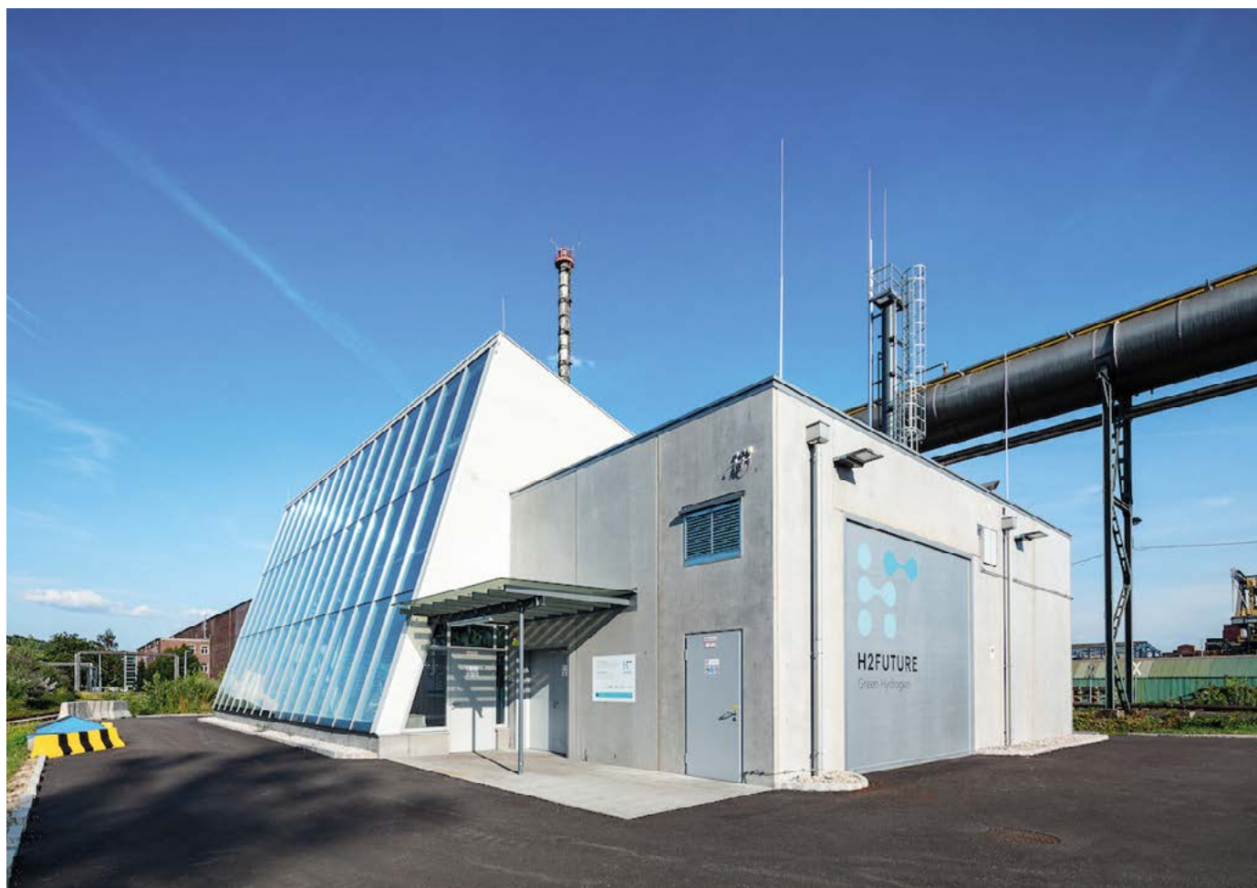
Obrázek 5: Zařízení na výrobu zeleného vodíku pomocí elektrolýzy vody (zdroj: ©VERBUND)
