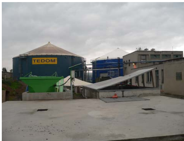
Obr. 8.1: Textilní dvouplášťový nasedlaný plynojem, obvykle polyesterová tkanina + PVC, nízkotlaký 0,5 – 2,5 kPa, životnost 20 – 30 let nabízí řada firem, v ČR např. Tomášek SERVIS s.r.o.
