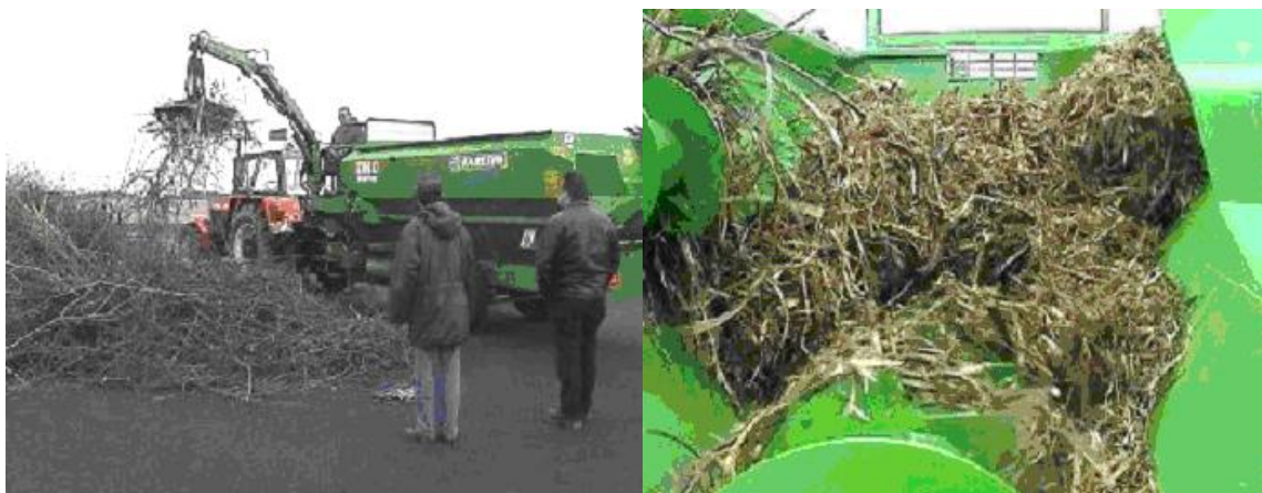
Obr. 5.15: Skládka EKOSO s.r.o. Trhový Štěpánov. Výroba štěpky z prořezaných křovin krmným vozem -drtičem.
