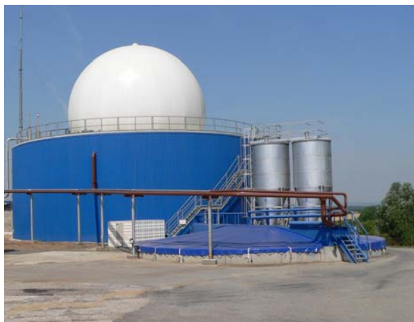
Obr. 8.2: Textilní dvouplášťový plynojem fy SATTLER (Rakousko) (objem 100 – 2150 m 3 , polyesterová tkanina + PVC, nízkotlaký 0,5 – 2,5 kPa, životnost 20 – 30 let) – firmu SATTLER zastupuje v ČR K & H Kinetic a.s.
