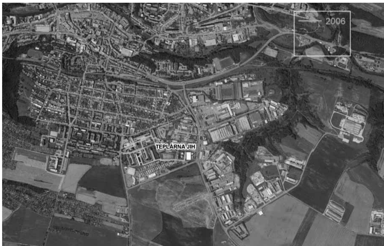
Teplárna JIH - rozvody v roce 2006
