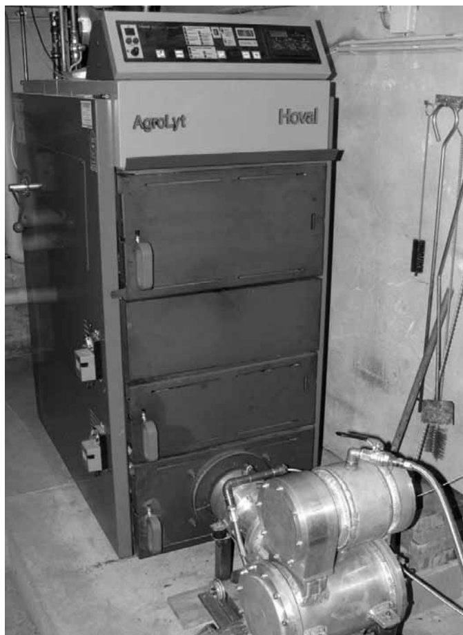
Hoval AgroLyt 25 kW se Stirlingovým motorem 1 kW, zdroj Hoval
