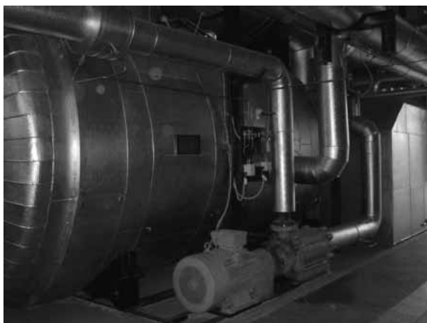
Duben 2005 - spuštění ORC turbíny 1 MWe
