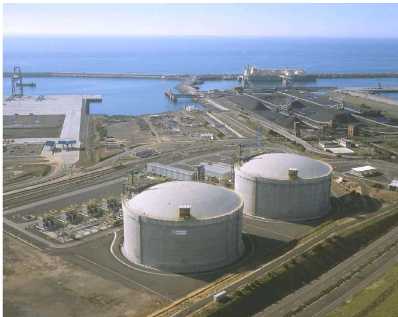
Obr.3.18: LNG terminál Sines, Portugalsko
