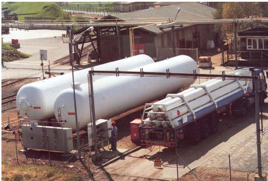
Obr. 3.56: Velkokapacitní tlakové zásobníky
