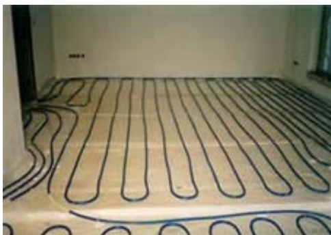
Obr .18. – Způsoby kladení otopného hadu
