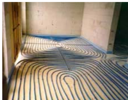
Obr .18. – Způsoby kladení otopného hadu
