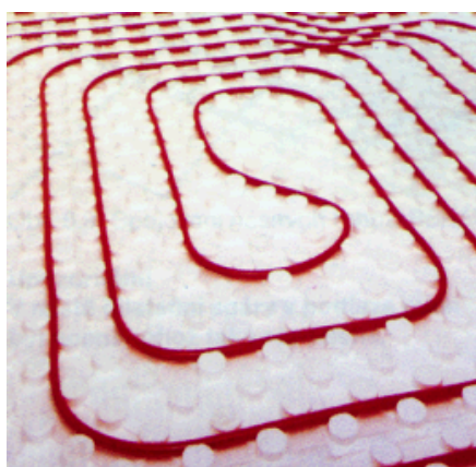
Pedotherm – uložení v systémové desce
