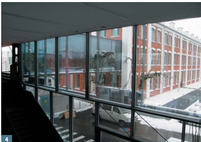
Obr. 2 Energon, 2002. Jedna z prvních administrativních budov v pasivním standardu, CO 2 neutrální. Železobetonový skelet s dřevěným obvodovým pláštěm. Celková podlahová plocha 8000 m 2 . Autor: oehler faigle archkom, Ulm, Německo
