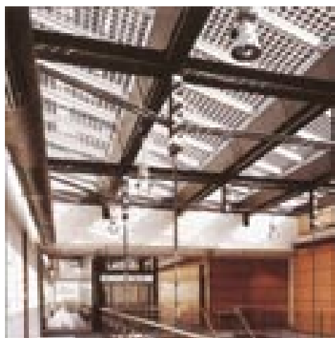
Transparentní část střechy se solárními články (obr. 5)
