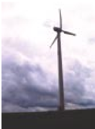
Větrná elektrárna Fuhrländer FL 100 u Protivanova v ploché vyvýšenině Dražanské vrchoviny (obr. 10, autor B. Koč)
