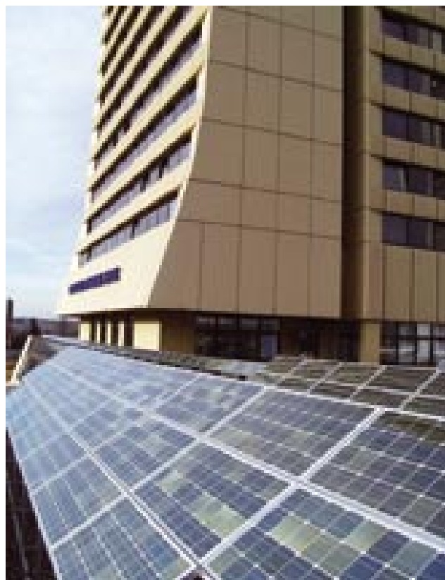
Fotovoltaický systém na budově hotelu Corinthia Panorama na Pankráci (obr. 8)
