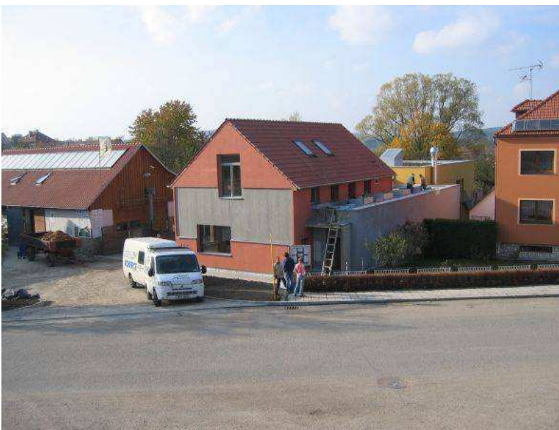
Nově postavené seminární centrum. Hostí ho nízkoenergetická budova. Centrum Veronica Hostětín bylo slavnostně otevřeno v říjnu 2006.
