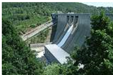
Obrázek 8 Vodní elektrárna Orlík
