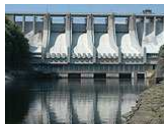
Obrázek 9 Vodní elektrárna Slapy
