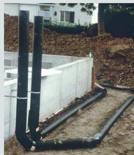
Obrázek 65: Položení zemního výměníku tepla v rozšířené pracovní oblasti budovy (zdroj: pasivní domy Wegere (CH), CEPHEUS, konečná zpráva 2001)
