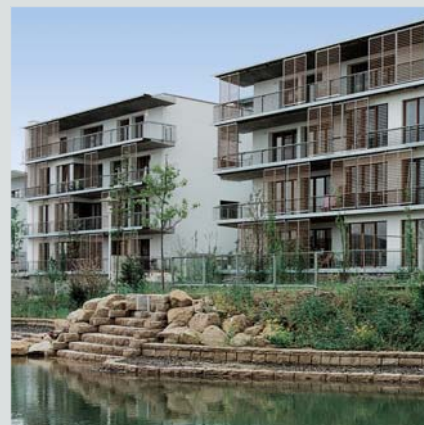
Obrázek 3: Bytové domy pro více rodin – sídliště Kronsberg, Expo Hannover
