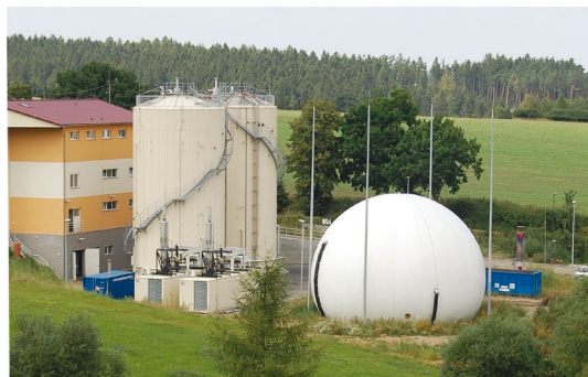
Obr. 3: Fermentační nádrž technologie luT
