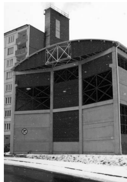
Žlutická teplárna vytápí biomasou celou obec. Jsou zde používány kotle firmy Verner, a. s. na slámu a štěpku.
