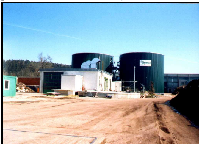
Foto 1: Pohled na bioplynovou stanici v Teugnu, SRN
