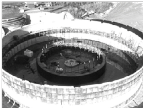
Obrázek 3–30: Stavba železobetonového fermentoru, foto: Johann Wolf GmbH & Co Systembau KG
