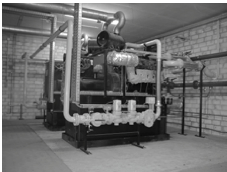
Obrázek 5–7: Kogenerační jednotka s plynovým hospodářstvím, foto: MT-Energie GmbH
