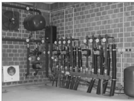
Obrázek 5–6: Rozdělovač tepla, foto: MT-Energie GmbH
