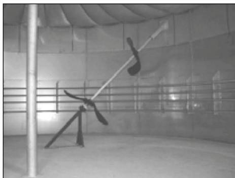
Obrázek 3–34: Dlouhoosá mísidla se dvěma míchacími nářadími s uloženíím u dna fermentoru nebo bez, foto: WELtec BioPower GmbH
