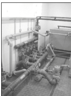
Obrázek 3–17: Čerpadla v bioplynové stanici, foto: WELtec BioPower GmbH
