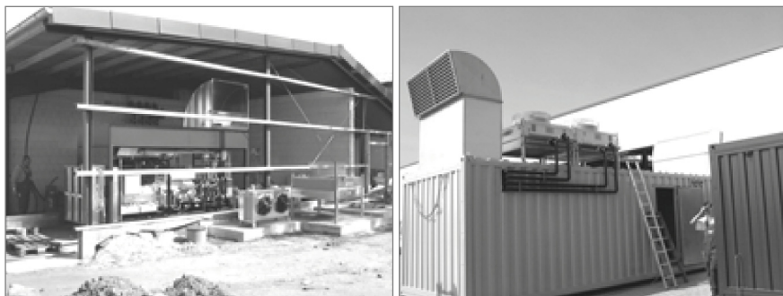
Obrázek 5–8: Kogenerační jednotka- kontejner popřípadě výstavba jedné kogenerační jednotky v budově; foto: Seva Energie AG
