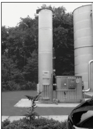
Obrázek 3–39: Nouzový hořák jedné bioplynové stanice, foto: Haase Umwelttechnik AG
