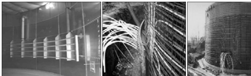
Obrázek 3–32: Rozložení nerezocelových rour topení ve fermentoru (vlevo); vestavba topných hadic do stěny fermentoru (uprostřed a vpravo), foto vlevo a uprostřed: Biogas Nord GmbH, foto vpravo: PlanET Energietechnik
