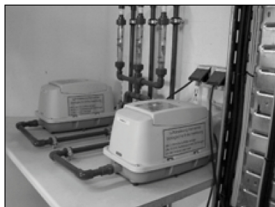
Obrázek 5–1: Regulace plynu pro vefukování vzduchu do prostoru biofermentorů. Foto: Institut pro energetiku a životní prostředí GmbH
