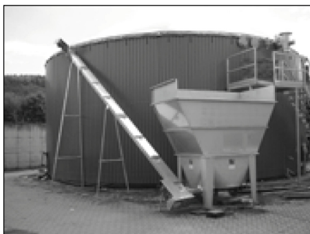
Obrázek 3–24: Vnášení kupivé biomasy vnášecími písty, foto: PlanET Energietechnik
