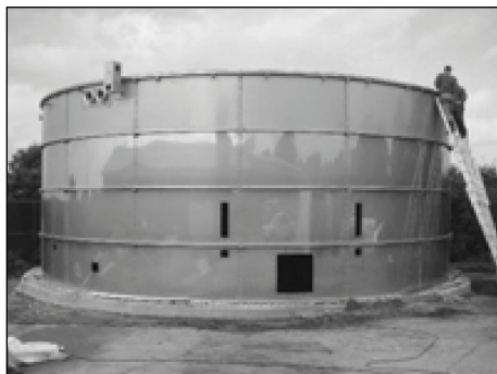
Obrázek 3–31: Nerezocelový fermentor, nacházející se ve výstavbě, foto: Stavitelství bioplynových stanic a přístrojů Lüthe GmbH
