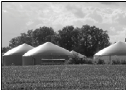
Obrázek 3–38: Spodní konstrukce nosné pneumatické střechy (vlevo); bioplynová stanice s nosnými pneumatickými střechami (vpravo), foto: MT- Energie GmbH
