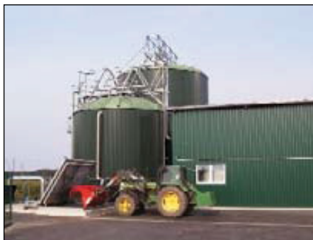
Obrázek 3–21: Přijímací jímka při dávkování, foto: Loick Bioenergi
