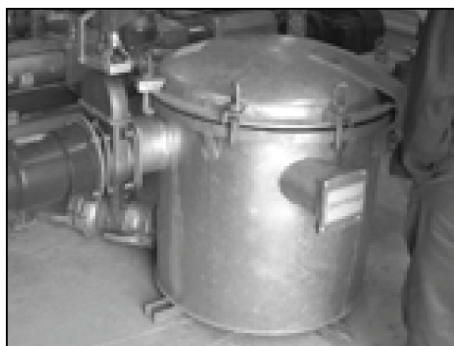
Obrázek 3–26: Odlučovač těžkých látek v jednom potrubí, foto: Institut pro energetiku a životní prostředí GmbH
