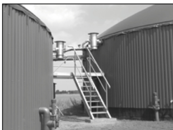
Obrázek 3–25: Pracovní lávka mezi dvěma nádržemi s potrubím a pojistkami tlaku, foto: MT-Energie GmbH
