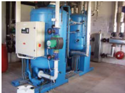
Obrázek 5–15: příklad absorpčního chladicího stroje na jedné bioplynové stanici, foto: Institut pro energetiku a životní prostředí GmbH
