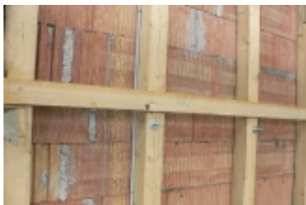
Obrázek 12: Nosný dřevěný rošt pro izolaci. Foto: K. Srdečný.
