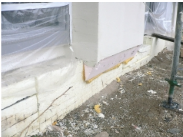
Obrázek 17: Napojení izolace stěn a základů (před provedením hydroizolační vrstvy a do-sypáním zeminy). Foto: K. Srdečný.
