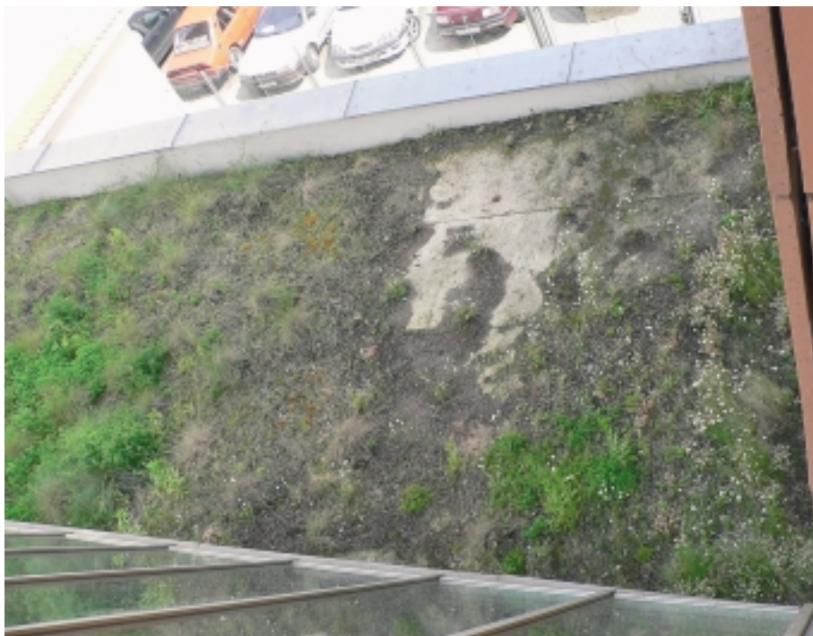
Obrázek 20: Zelená střecha, kde došlo k částečnému splavení substrátu. Foto: K. Srdečný.
