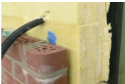
Obrázek 13: Zateplení s přízdívkou u pohledového zdiva. Foto: K. Srdečný.
