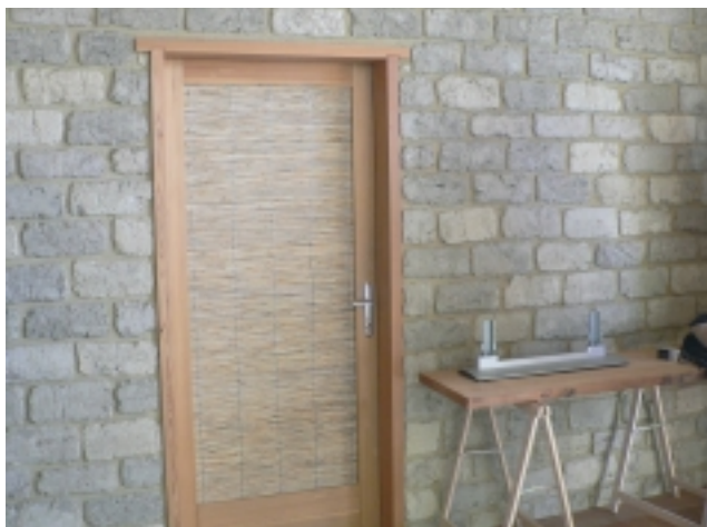
Obrázek 29: Vnitřní stěna z nepálených cihel kvůli zvýšení akumulační schopnosti domu. Foto: J. Truxa
