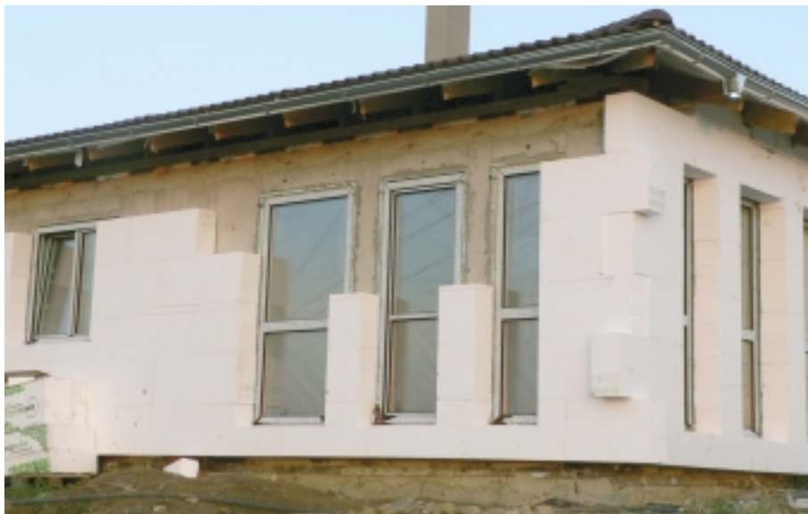
Obrázek 16: Stěny z monolitického betonu umožňují použití pro zateplení libovolnou tloušťku izolantu. Foto: K. Srdečný.
