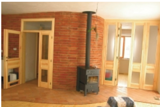
Obrázek 30: Interiérová kamna s teplovodním výměníkem jsou oblíbeným doplňkem vytápěcího systému. Foto: A. Brotánek
