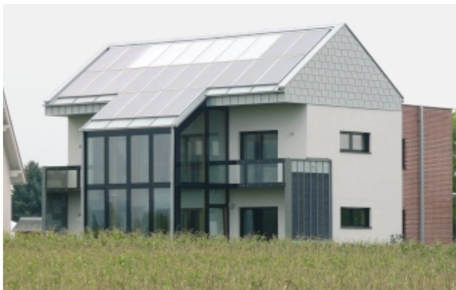
Obrázek 32: Solární systém pro ohřev vody (světlejší) a fotovoltaický systém pro výrobu elektřiny pokrývající celou jižní střechu domu.
