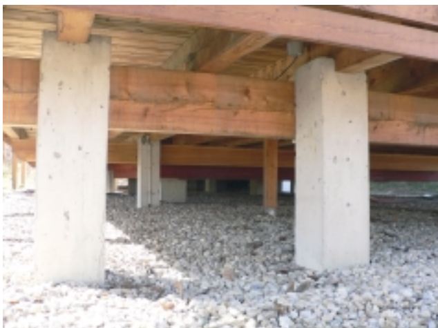
Obrázek 18: Založení stavby na patkách zapuštěných v terénu. Foto: K. Srdečný.
