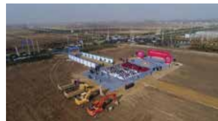
Výstavba bioplynové stanice v čínském Chuaj-anu (zdroj: HoSt)
