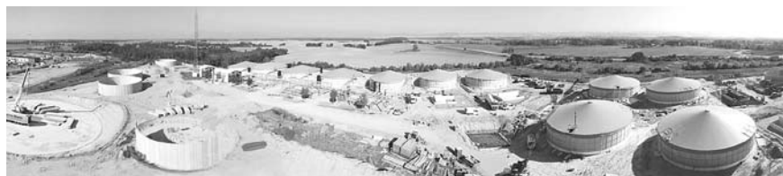
Panoramatický pohled na staveniště bioplynového parku
